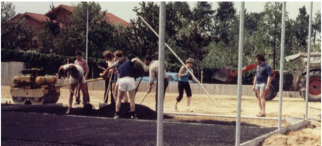
Nach der Begradigung des Untergrundes wurde die schwarze Schlacke als Zwischenschicht aufgetragen.
